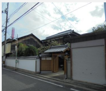
■ 塀・棟門【完成後】
