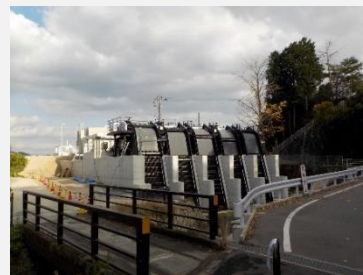
■川西ポンプ場
