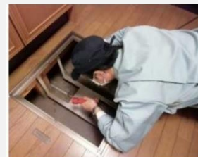
「土台・床組、基礎」調査の様子
