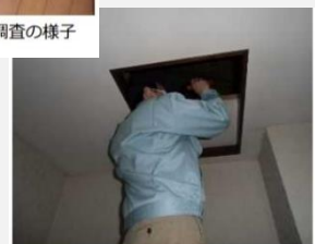
「小屋組・梁」調査の様子
