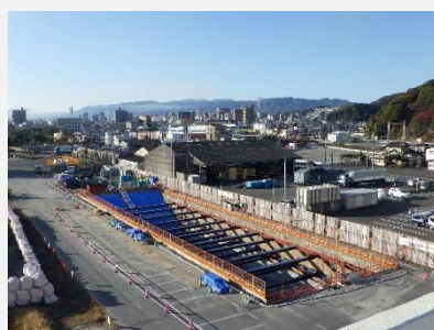
■一文字雨水調整槽 [全景 (工事中)]
