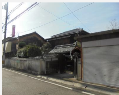
■ 塀・棟門【着手前】
