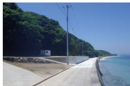
柱島農道大町2号線護岸改修工事
