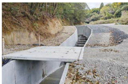
麻生田水路改修事業
