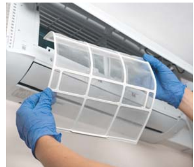
小まめなフィルター掃除もエアコンの省エネな使い方の一つ
