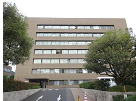
山口地方合同庁舎 2 号館外観
