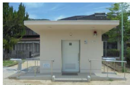
都市公園トイレ等改修事業
