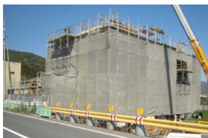
装束ポンプ場整備事業
