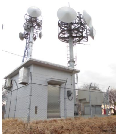
防災無線中継所
