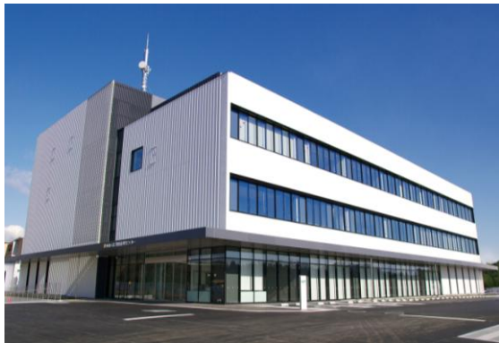
防災センター
