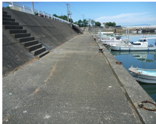
通津漁港物揚場
