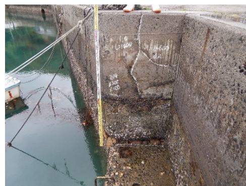
端島漁港物揚場
