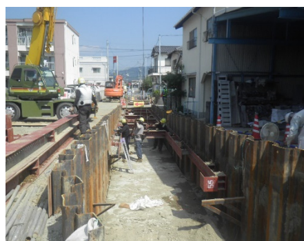
管路施設整備
