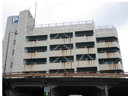
三笠橋駐車場
