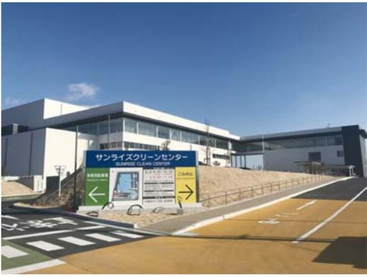
▲焼却の際に発生する熱で発電した電力は、隣接する余熱利用施設や電力会社へ送られる
