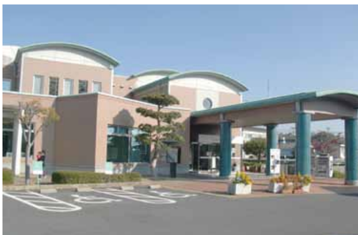
岩国市中央図書館（南岩国町四丁目）
