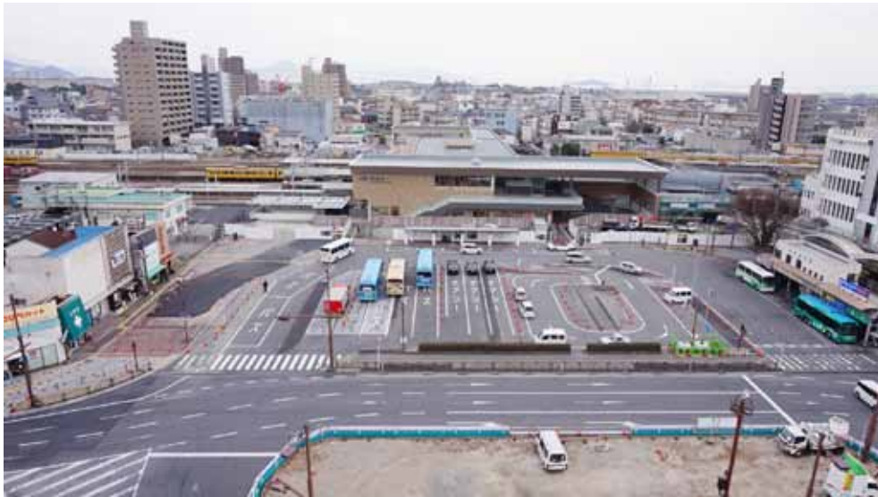
整備済みの J R 岩国駅と整備を行う駅前広場（西側）2019（平成31）年 1 月時点
