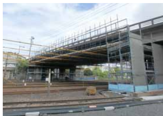
橋りょうの補修（三笠橋）
