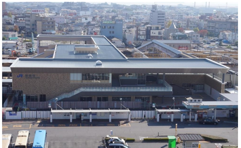
岩国駅東西自由通路及び橋上駅舎(西口)
