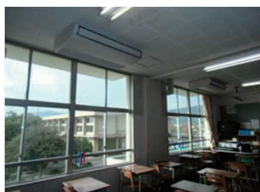
小・中学校の空調設備の整備
