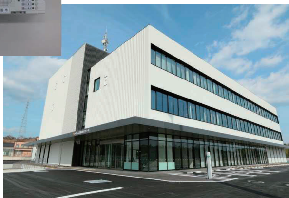
いわくに消防防災センターの整備
