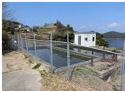
柱島浄水場緩速ろ過池
