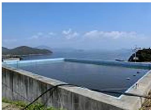
柱島浄水場原水槽
