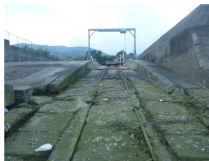
通津漁港船揚施設
