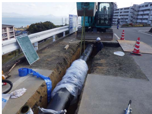
送水管布設整備工事
