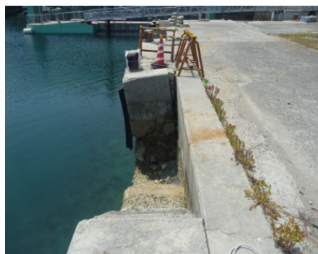
端島漁港物揚場
