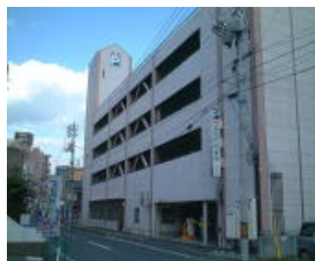
麻里布駐車場
