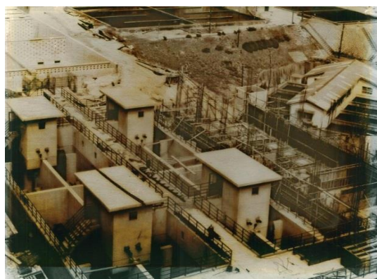
錦見浄水場管理棟（昭和46年工事中）
