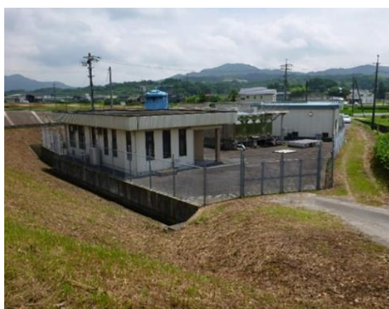
高森南浄水場
