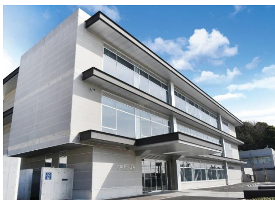
水道局新山手庁舎（山手町4-4-14） 〈令和元年5月供用開始〉
