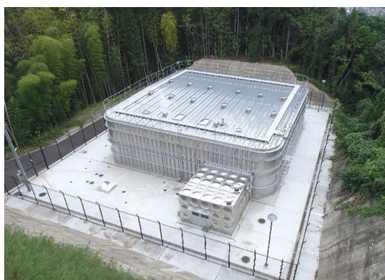
由宇統合配水池
