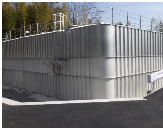
牛野谷配水池
