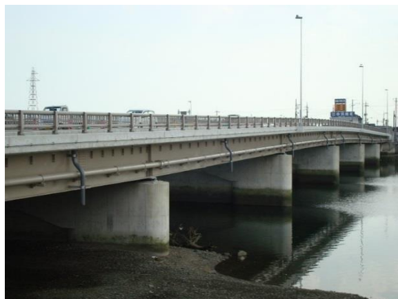
新寿橋添架配水管
