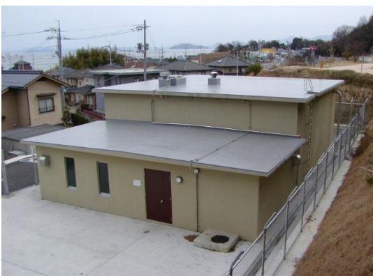
通津ポンプ所
