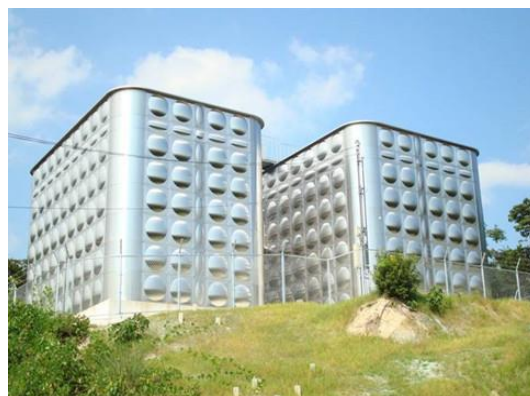
山手ブロック配水池
