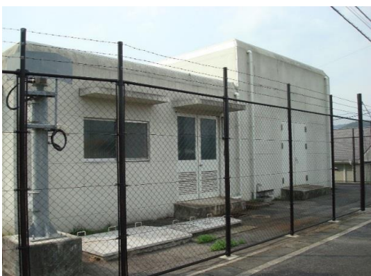
平田ポンプ所
