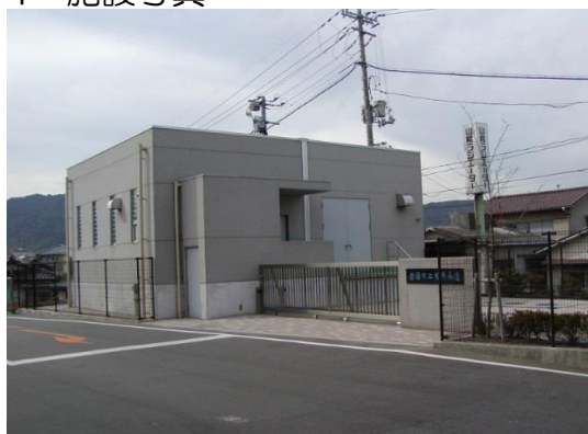
ポンプ所外観
