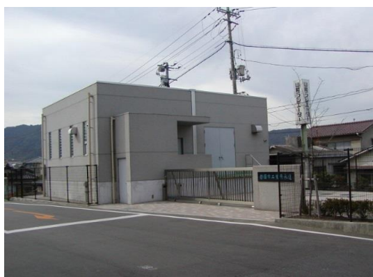
ポンプ所外観
