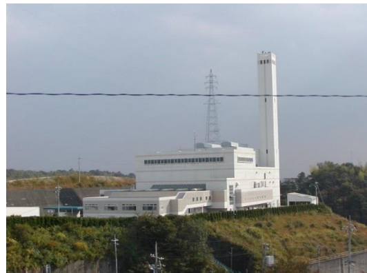
給水先 岩国市第一工場
