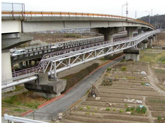
愛宕橋水管橋
