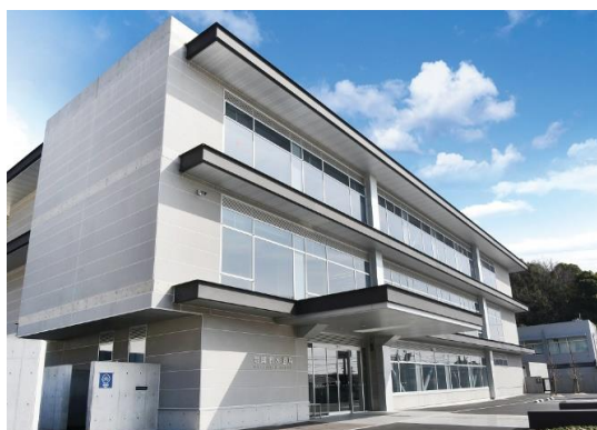
水道局新山手庁舎（山手町4-4-14） 〈令和元年5月供用開始〉
