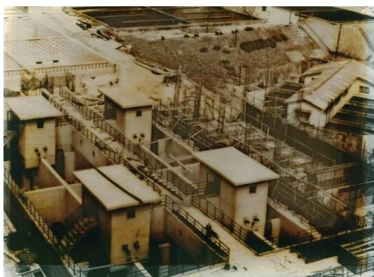
錦見浄水場管理棟（昭和46年工事中）
