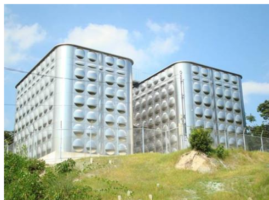
山手ブロック配水池
