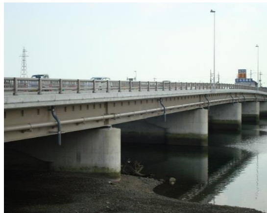
新寿橋添架配水管
