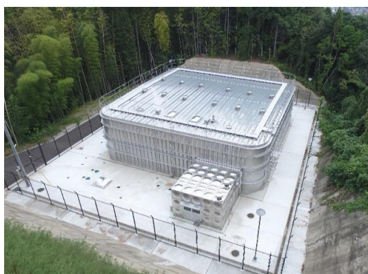
由宇統合配水池
