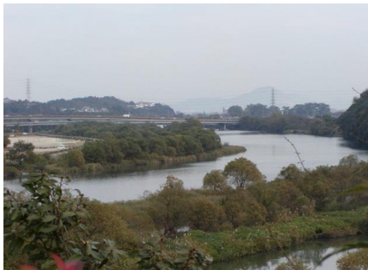
水源（錦川伏流水 集水埋管で取水）
