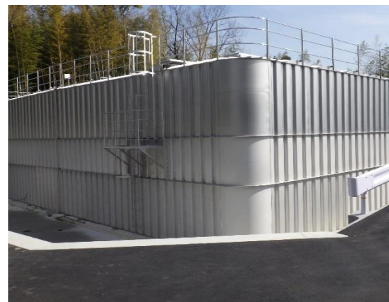
牛野谷配水池
