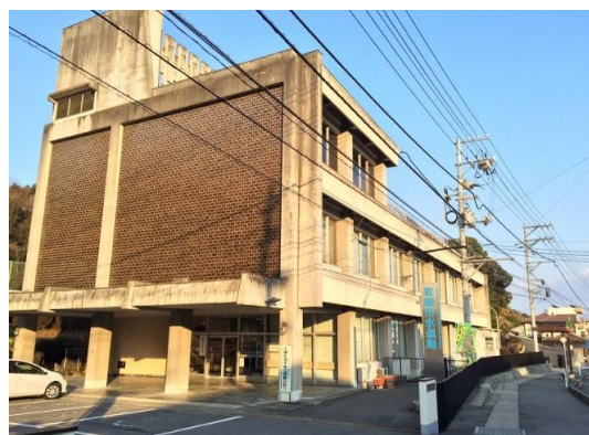
旧水道局山手庁舎（山手町4-4-14） 〈昭和48年～平成31年4月〉
