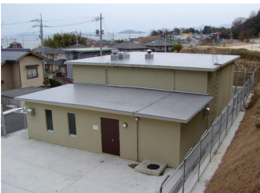
通津ポンプ所
