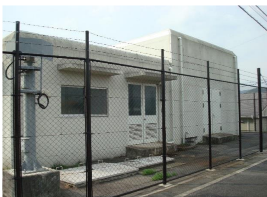
平田ポンプ所
