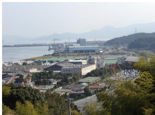
給水先 通津沖工業団地
