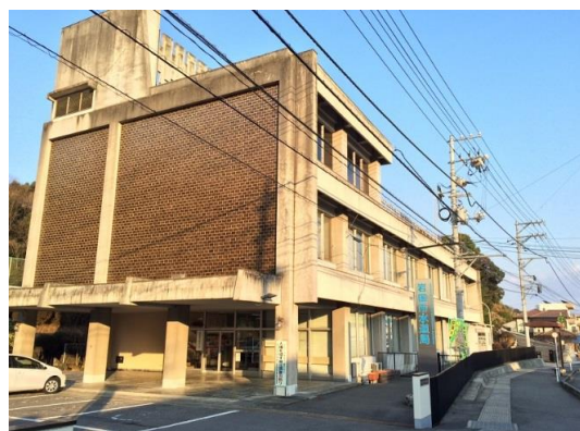
現水道局山手庁舎（山手町4-4-14）
