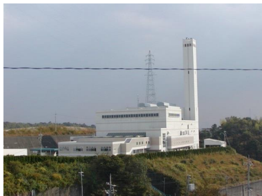
給水先 岩国市第一工場
