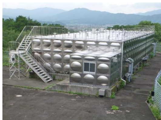
高森南配水池
