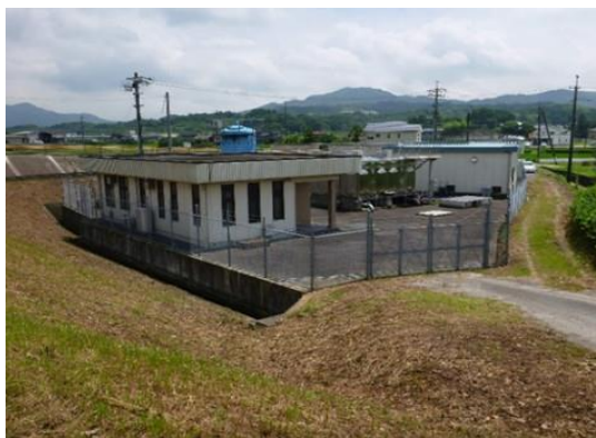
高森南浄水場
