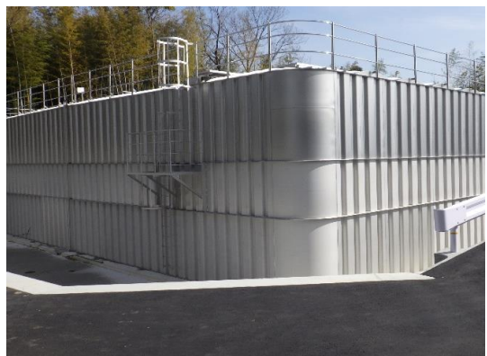
牛野谷配水池
