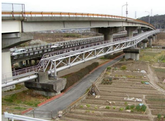
愛宕橋水管橋
