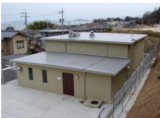
通津ポンプ所
