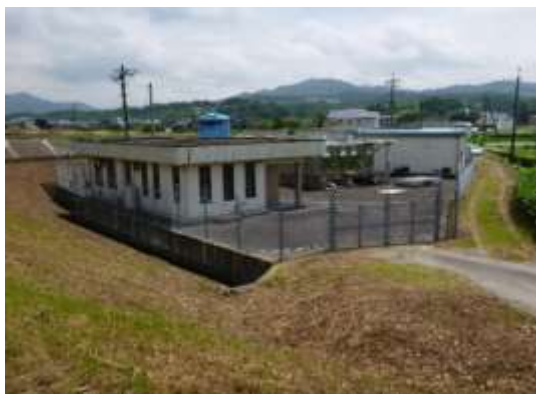
高森南浄水場
