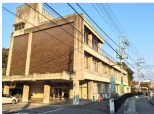
現水道局山手庁舎（山手町4-4-14）
