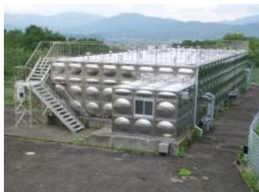
高森南配水池
