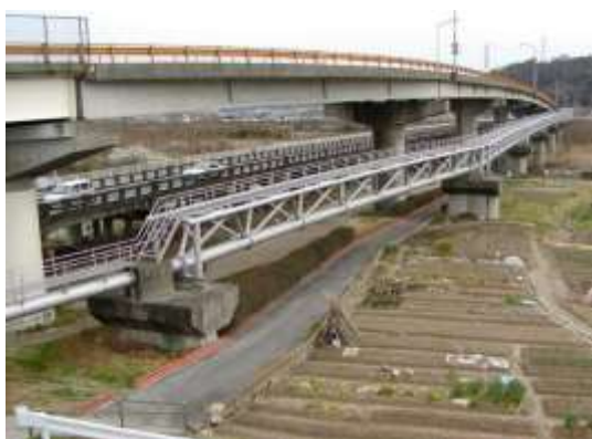
愛宕橋水管橋
