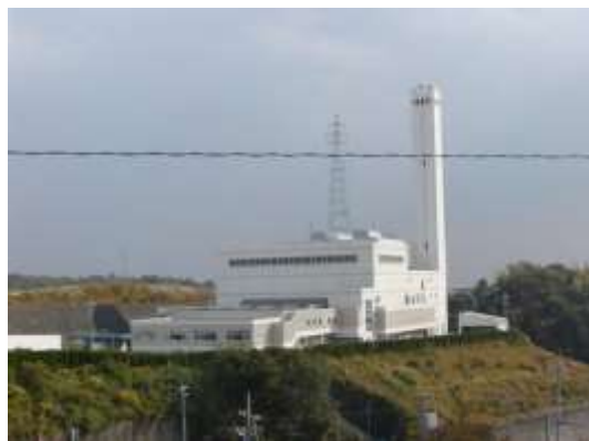
給水先 岩国市第一工場
