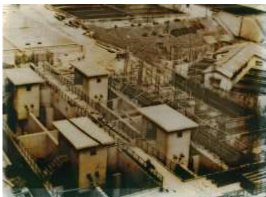
錦見浄水場管理棟（昭和46年工事中）
