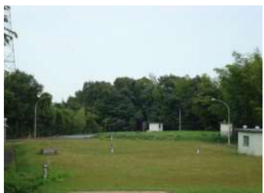
牛野谷配水池
