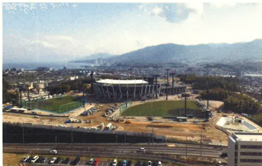
野球場などの工事实施状況
