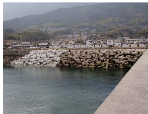
黒磯港消波ブロック
