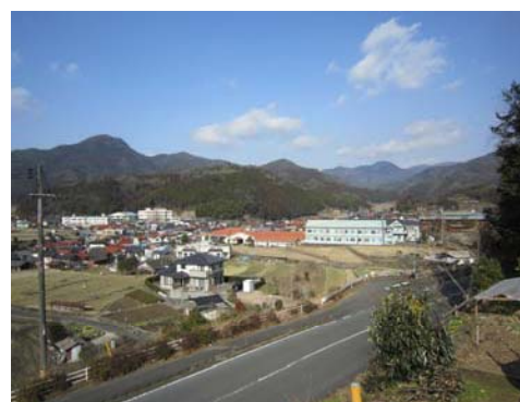
本郷簡易水道給水区域全景
