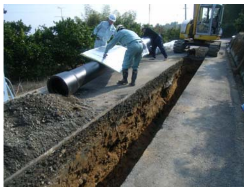
配水管布設工事
