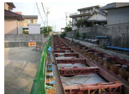
管きよ工事（門前町）
