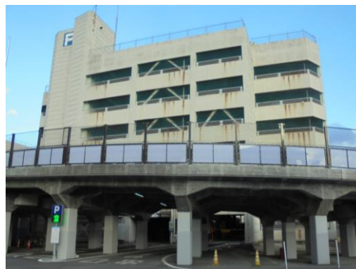
三笠橋駐車場
