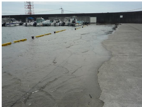
今津川船溜り物揚場
