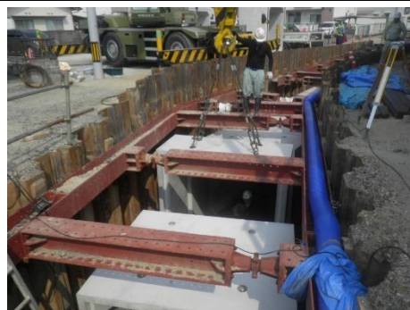
管路施設整備（門前町）
