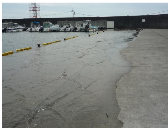
今津川船溜り物揚場
