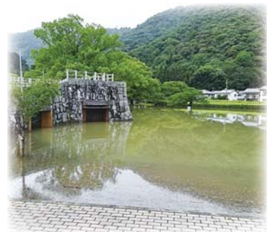
▲平成30年7月豪雨で浸水した吉香公園
