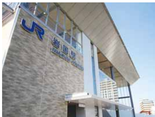
▲自由通路の出入口と屋根は、多くの人を迎え見送る「門」をコンセプトにデザインされている
