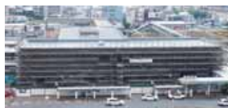
▲建設中の岩国駅西口
